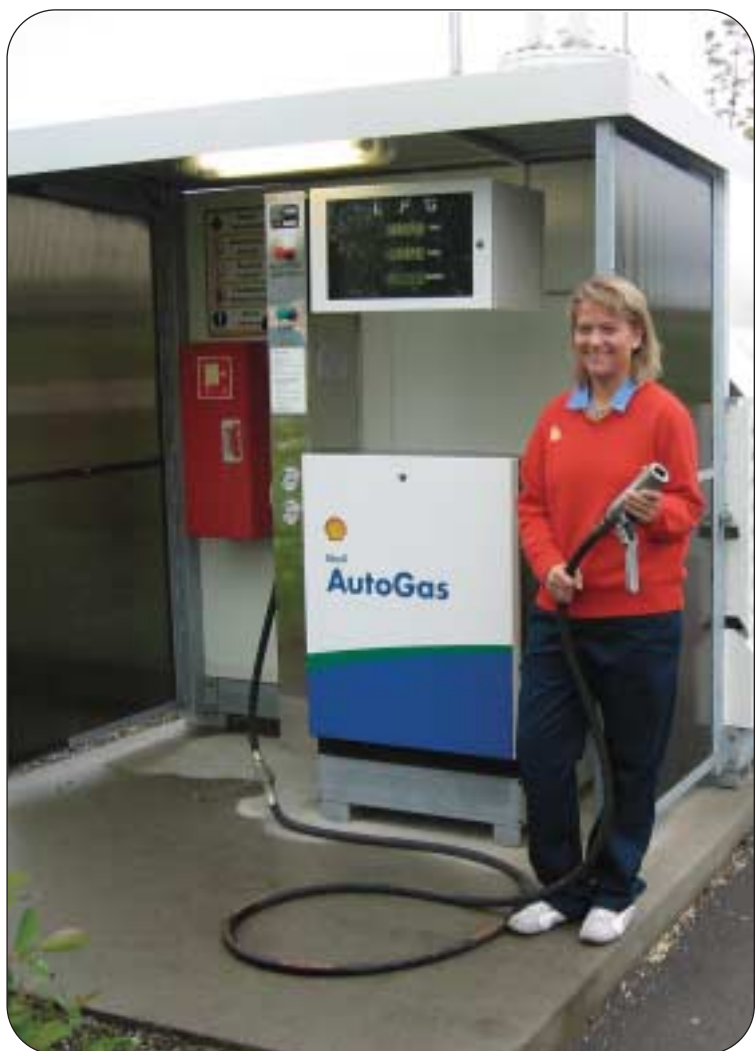
Klar for gassfylling. Ellinor Eriksson ved Shell-stasjonen på Kløfta, yder kundene hjelp ved påfyll av autogass. Stasjonen, som er en av landets rundt 75 autogasstasjoner, er levert til Shell av Gas Tech.
